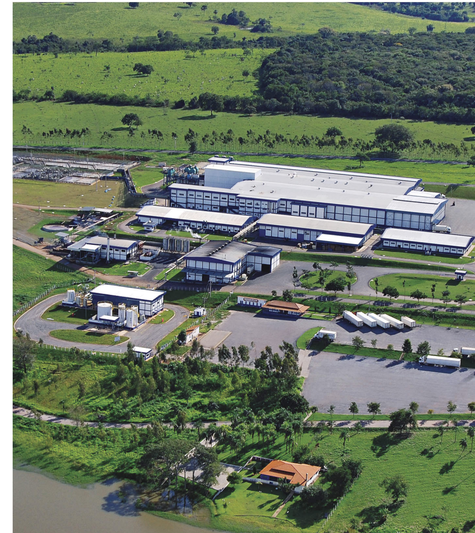
Unidade Industrial e Biodiesel / Palmeiras de Goiás
